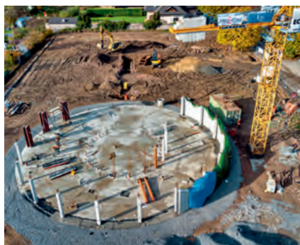
Stavba smuteční síně. Foto Radek Štěpán
