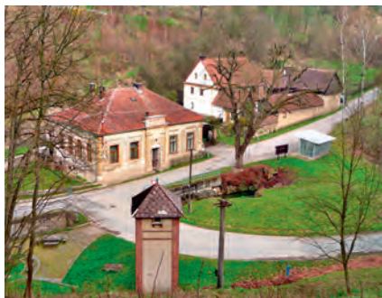
Bývalou trafostanici ve Svařeni najdete přímo na návsi. Foto archiv obce Svařen
